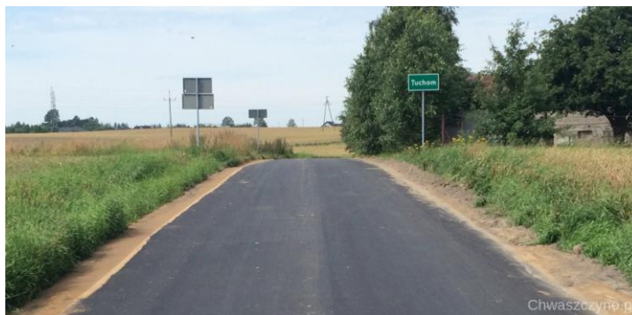
Świeżo wykonany odcinek ul. Długiej w Tuchomiu
