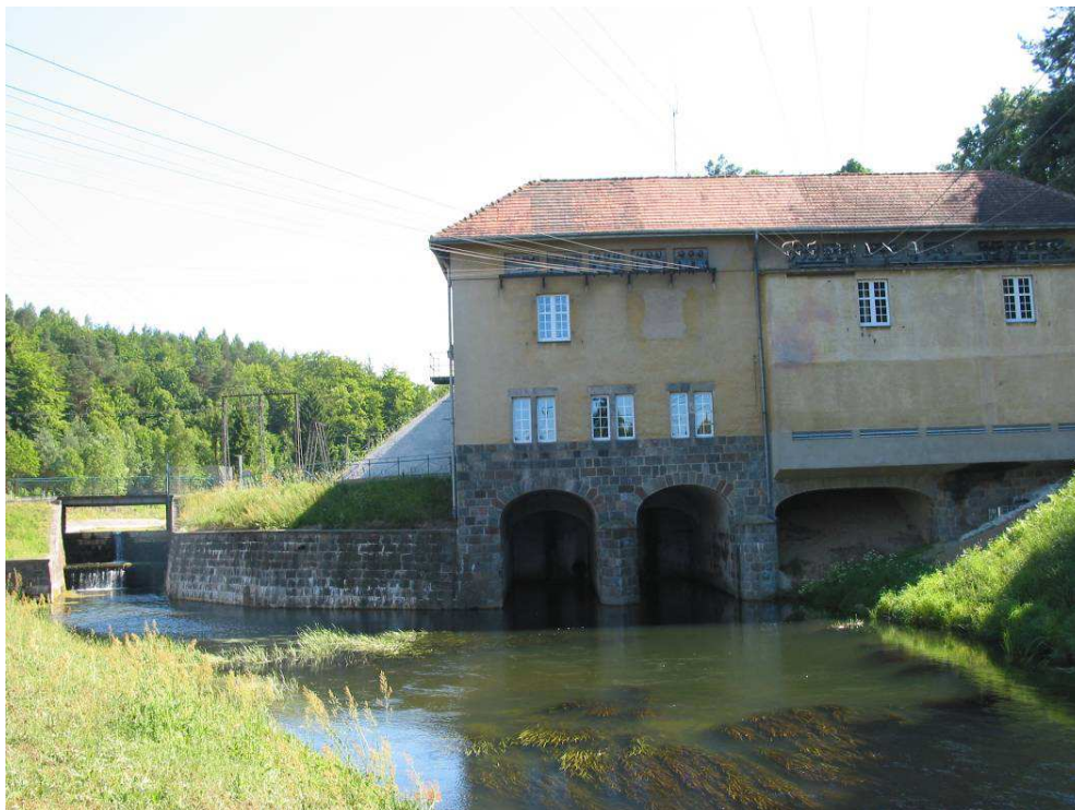
Rysunek. Elektrownia wodna w Rutkach
